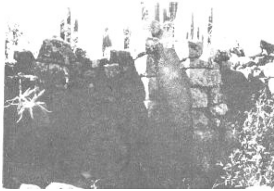
MUROS INTERNOS DE UNA HABITACION DEL GRAN TEMPLO DE ORONCOTA, de planta escalonada, en donde se puede apreciar el fino trabajo de la piedra. Aunque hoy está muy destruida, es uno de los grandes templos incaicos de Bolivia. Provincia Linares, Potosí, sobre el Pilcomayo
